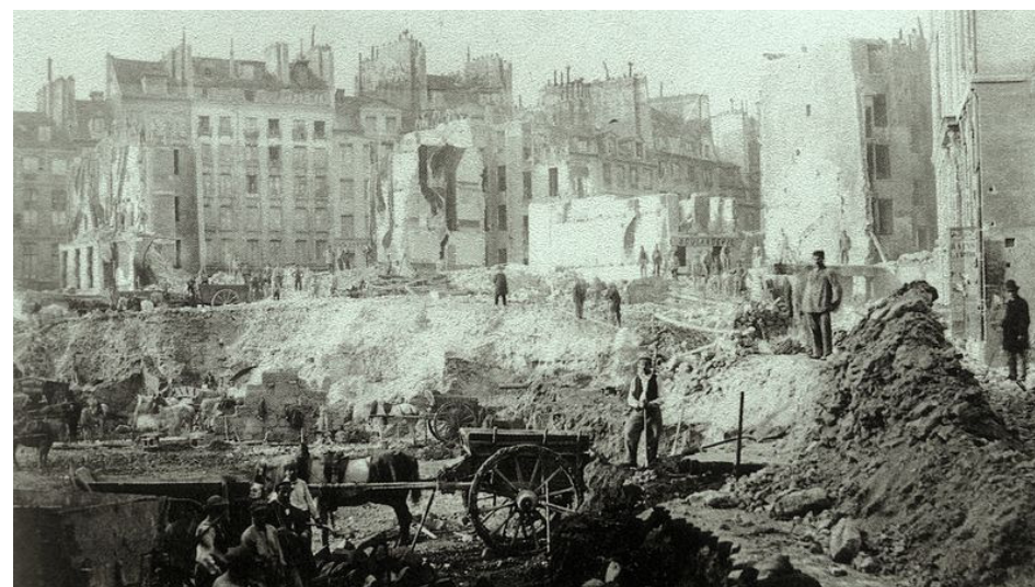
Burzenie Butte des Moulins pod Avenue de l'Opéra
