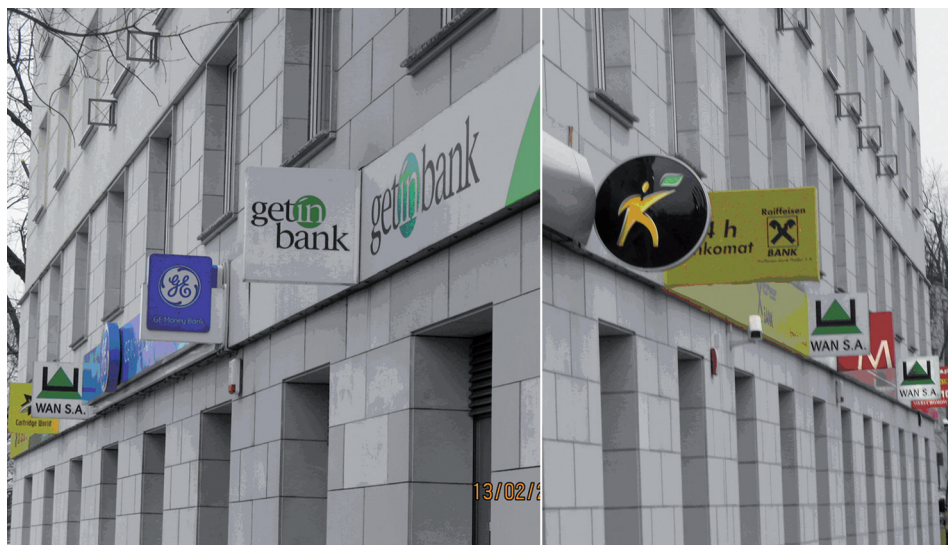
Fot. 1. Budynek przy ulicy Hanki Czaki 2/4 od strony ulicy Słowackiego (strona lewa) i ks. Popiełuszki (strona prawa)
