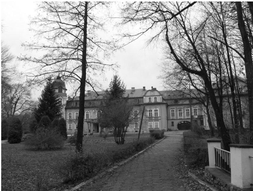
Ryc. 1. Widok na elewację frontową pałacu w Żelaźnie. Źródło: opracowanie własne.
