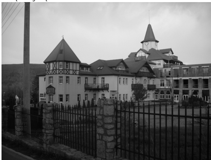
Ryc. 4. Nowa zabudowa pensjonatowa. Źródło: opracowanie własne.
